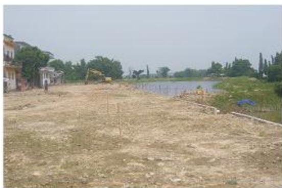
村前塘基已平整好，准备铺水泥
