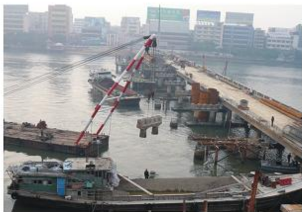
潭江大桥重建在施工中 余文海报
